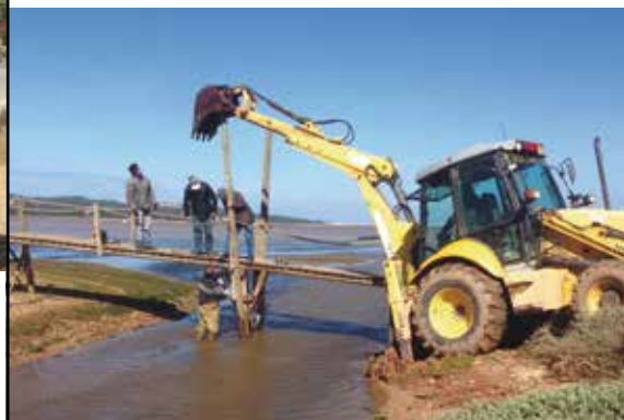
ARELHO Reparação da ponte junto ao Parque das Merendas
