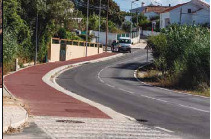
A-DA-GORDA Ecopista e Repavimentação da Estrada Real
