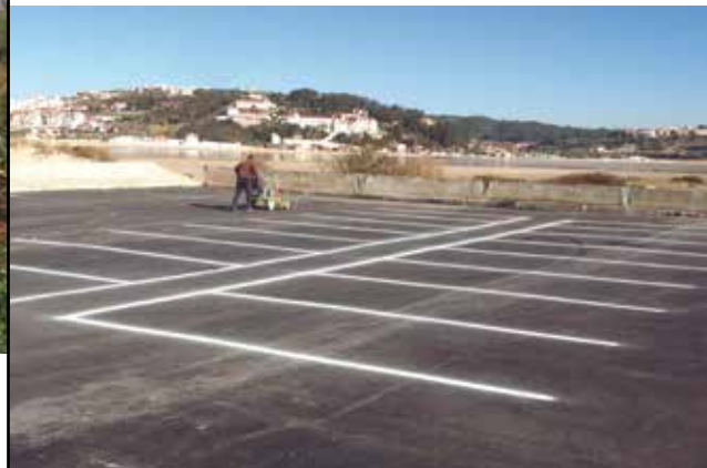
VAU Pavimentação e Marcação Horizontal Estacionamento Aldeia dos Pescadores, Bom Sucesso
