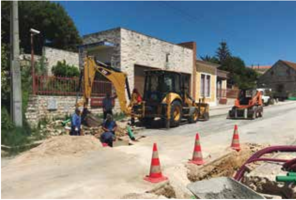
A-DOS-NEGROS 1ª fase da Requalificação da Estrada Principal
