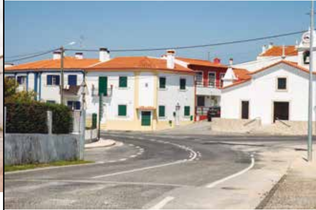
BAIRRO DE SENHORA DA LUZ Requalificação e Marcação Horizontal Estrada Bairro de Senhora da Luz
