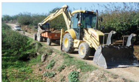
Usseira _Limpeza e recuperação de pontões nos caminhos rurais
