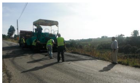
Vau _Reparação de estradas e ruas com alcatrão em toda a área da Freguesia, com o acompanhamento do Presidente da Junta de Freguesia
