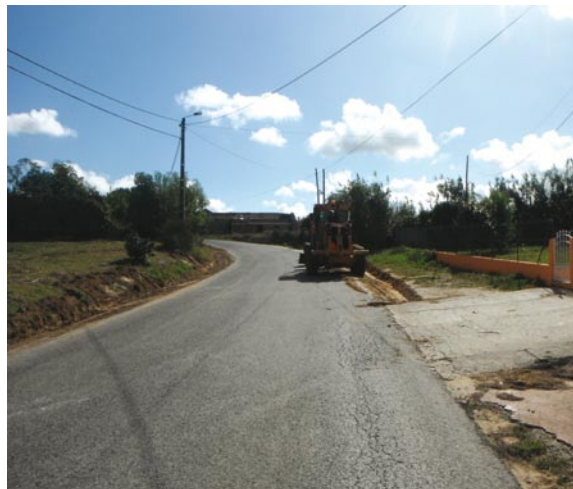
Usseira _Limpeza das valetas e aquedutos da Rua Manuel Teotónio e outras, com a colaboração da Junta de Freguesia
