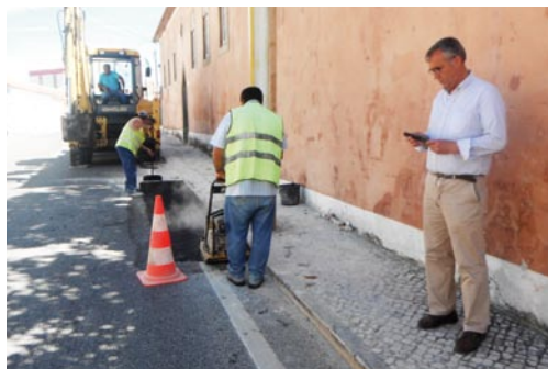
Gaeiras_Mantenção e reparação de roturas na Vila
