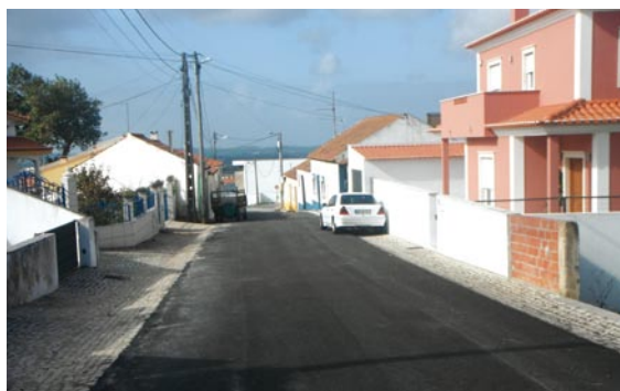
Gaeiras _Preparação, alcatroamento e calcetamento da Rua Vale dos Ventos
