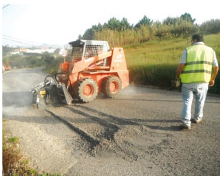
Amoreira _Reparação das ruas e estradas com alcatrão em toda a área da Freguesia, com a colaboração da Junta de Freguesia
