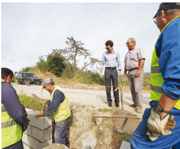
Vau _Início da requalificação e alargamento da estrada dos Barreiros
