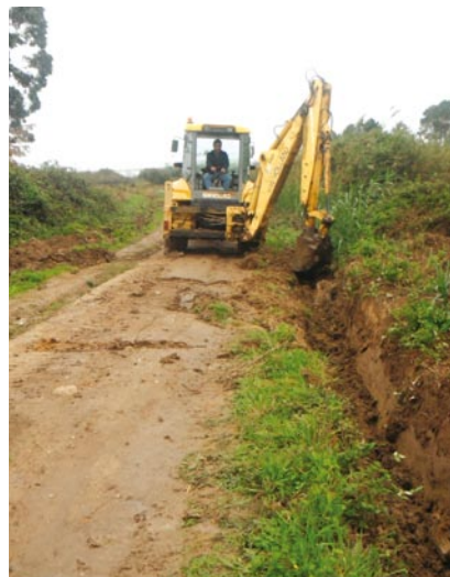
Olho Marinho_Limpeza de linhas de água em toda a área da Freguesia, em colaboração com a Junta de Freguesia
