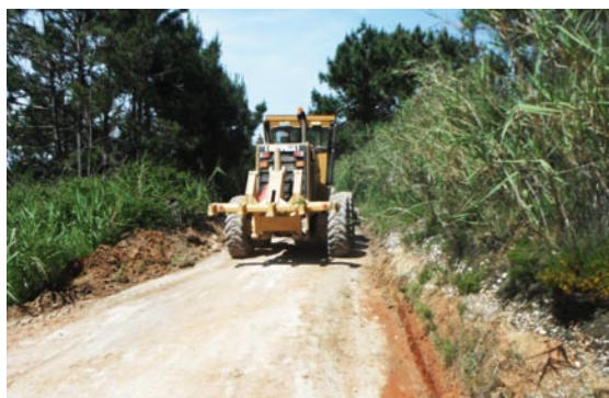
Amoreira _Limpeza e manutenção de caminhos rurais
