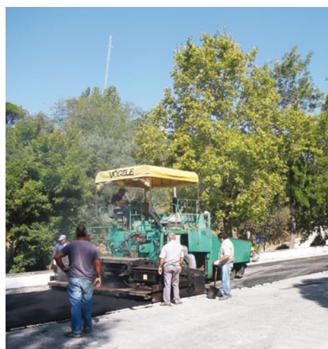
Santa Maria, São Pedro e Santa Maria_Preparação e alcatroamento em diversos locais da Freguesia
