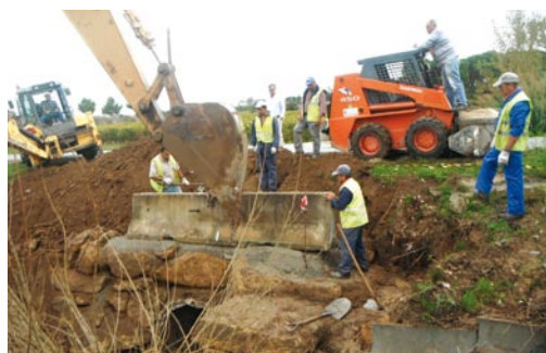
Gaeiras _Reparação de aqueduto na estrada da Califórnia
