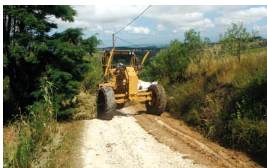
A-dos Negros _Manutenção de caminhos rurais e limpeza de valetas, na área da Freguesia
