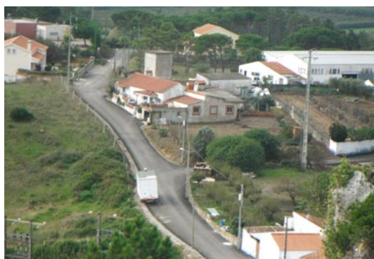
Santa Maria, São Pedro e Santa Maria_Continuação do saneamento e alcatroamento das Ruas no Novo Mundo, em A-da-Gorda
